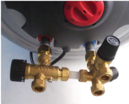
LK Armatur varolaiteryhmä termostaattisella sekoitusventtiilillä
